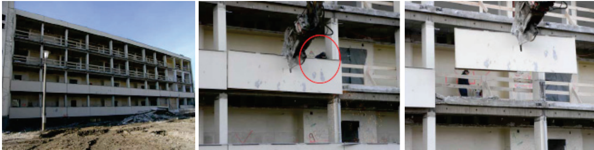
Demontage der Brüstungselemente 1
